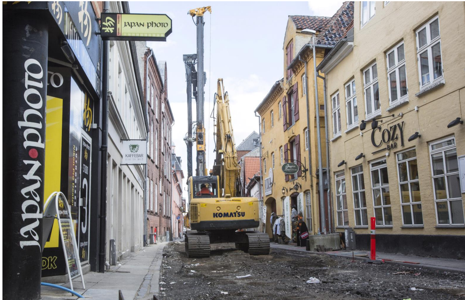
Olav Bennike Kloak A/S Byggestyring- og Koordinering
